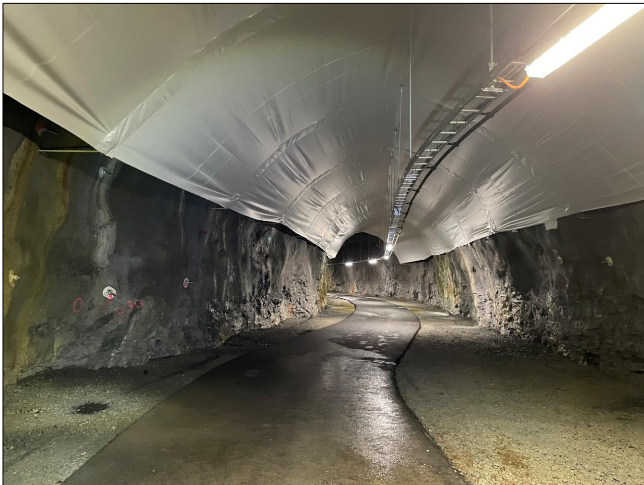
Foto 19: Giertsen tunnelduk er montert fra vederlag til vederlag i tunnel B, i parti ved inngangen til tunnelrommet og før utgangen til gateplan. Nødtunnel B er sikret med sprøytebetong og sikringsbolter til ca 1-1.5 m over såle. Tunnelen er gjennomgående fuktig med flere dryppsoner.
