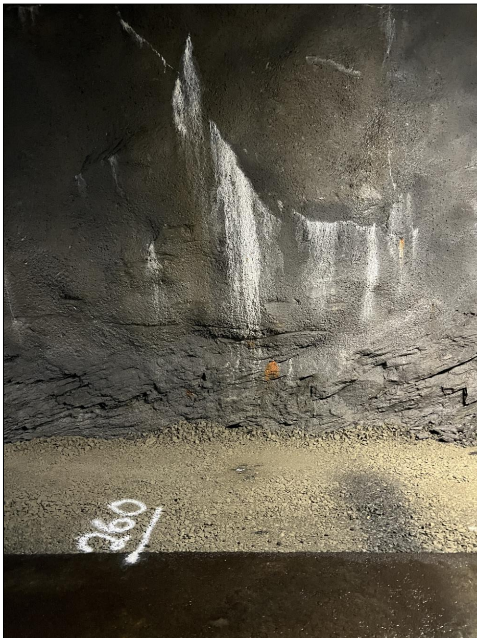
Foto 17: Kalkutfelte riss i nedre vegg mot såle.
