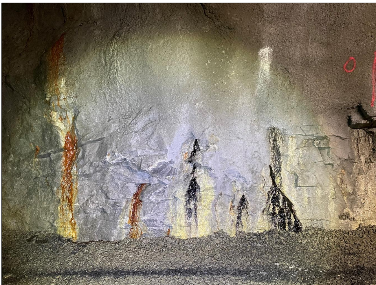
Foto 20: Diverse rust og utfelling i nødtunnel B.
