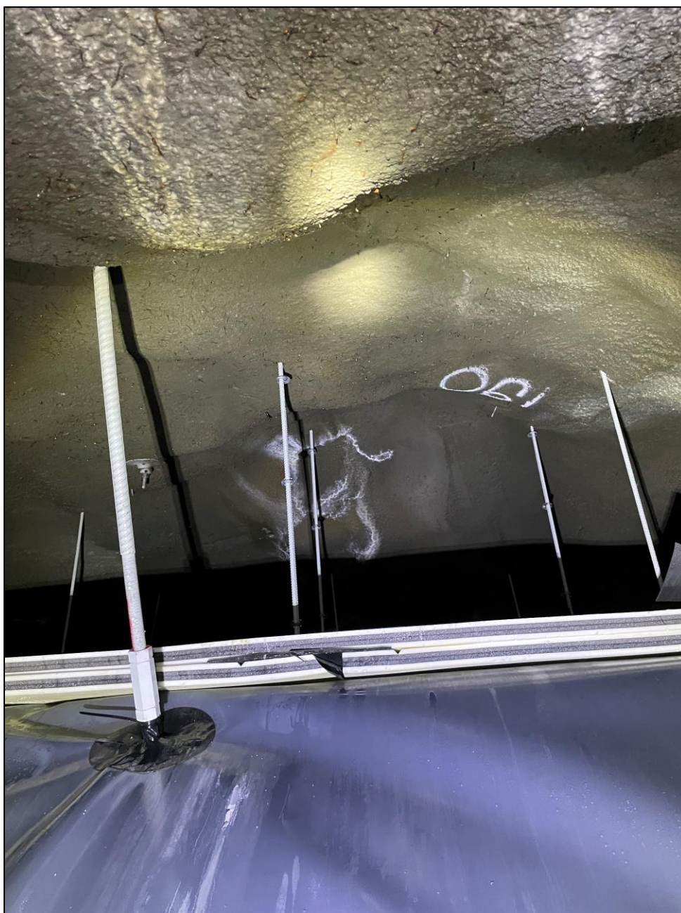
Foto 11: Kalkutfelte riss i vederlag – heng. Gjennomgående fukt i profilet.
