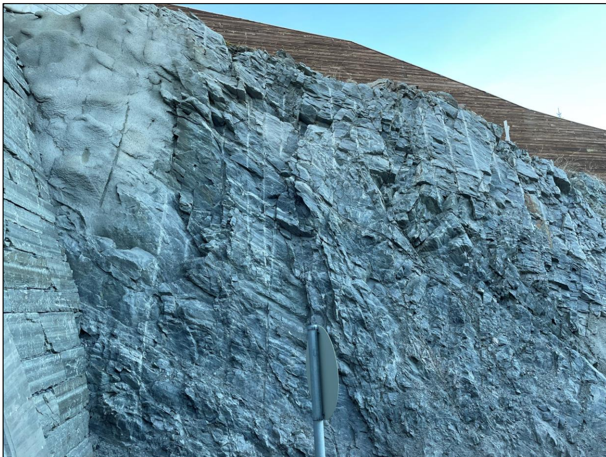
Foto 3. Oversikt forskjæring sør, høyre forskjæringsvegg. Berget fremstår småfallent og rufsete i toppen. Det er observert nedfall av mindre steiner i grøften. Det er ca. 2-3 m grøft frem til vegkant.
