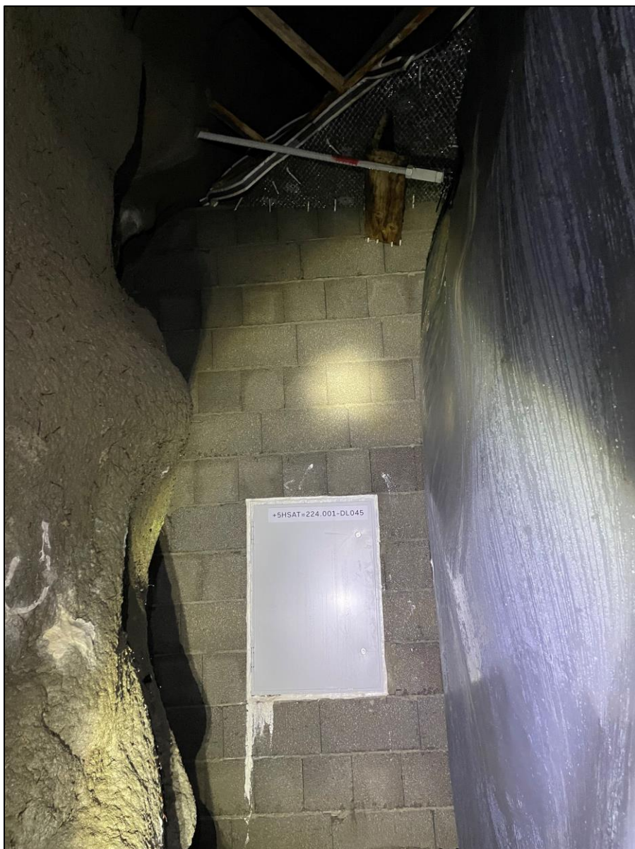
Foto 13. Inspeksjonsluker i brannmur bak hvelv.
