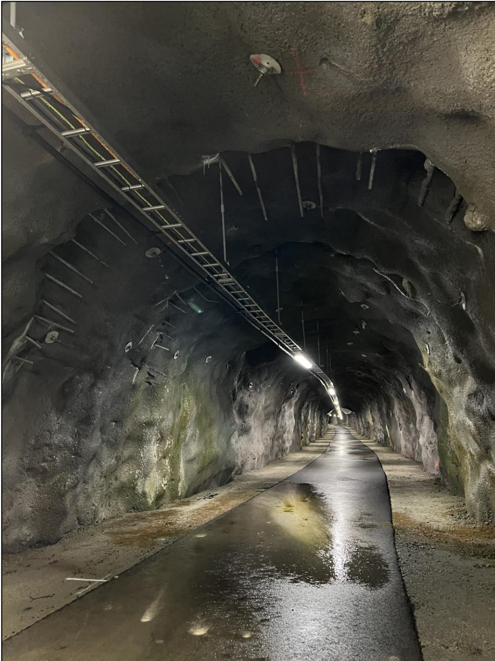
Foto 16: Tunnelen er stort sett sikret med sprøytebetong ned til sålen. Sikringsbolter er kun installert fra øvre vegg/vederlag. Tunnelen er gjennomgående fuktig med flere dryppsoner.
