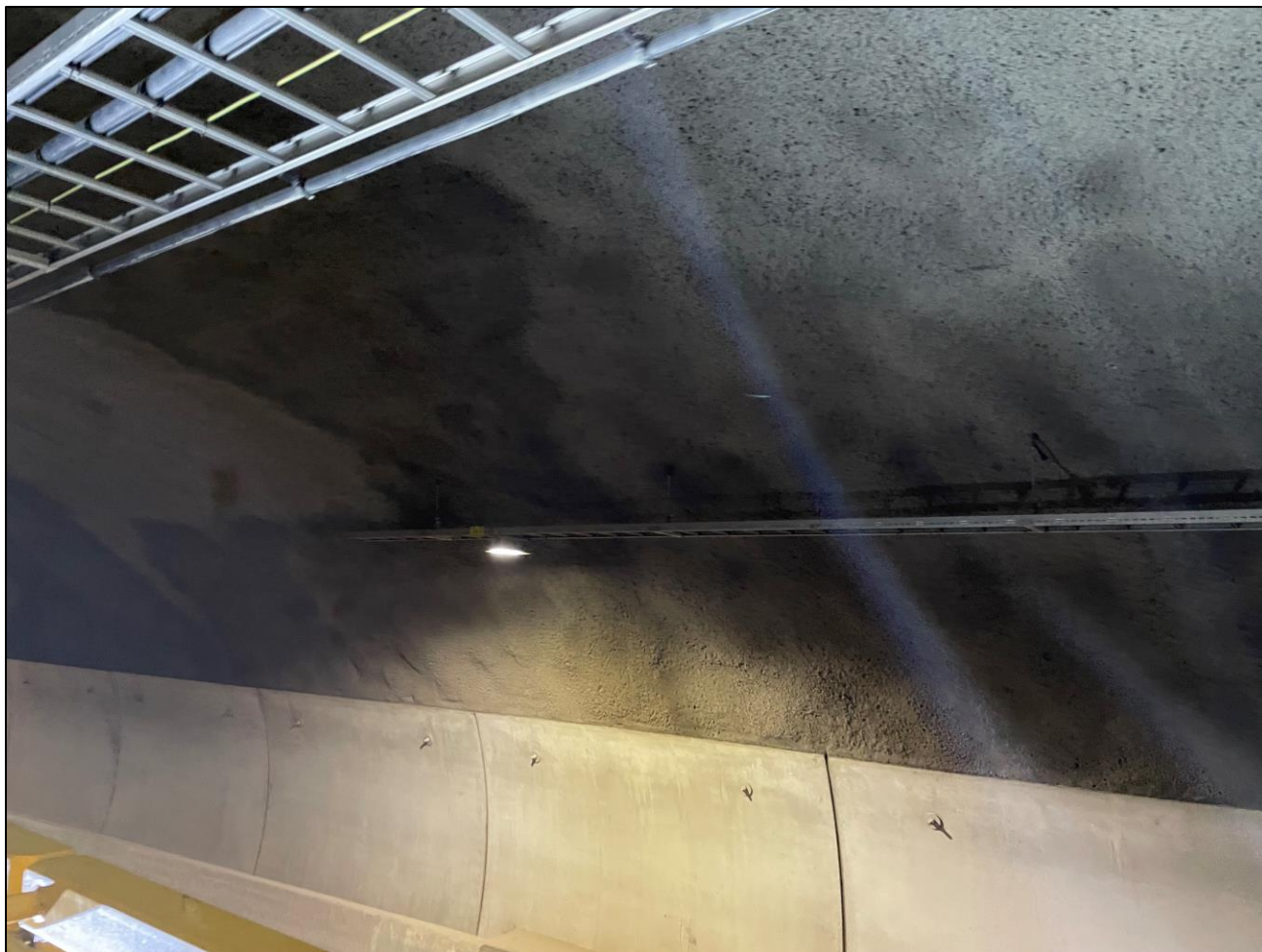
Foto 6. Tunnelen fremstår med gjennomgående fukt. Stedvis sporadisk i vegg og heng, og stedvis gjennomgående i hele profilet.
