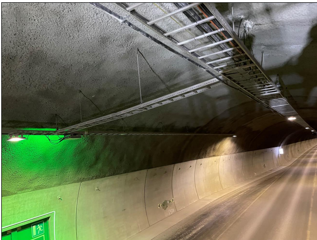
Foto 5. Generelle forhold i Harstadåstunnelen. Tunnelen er dekket med veggelement og PE-skum.
