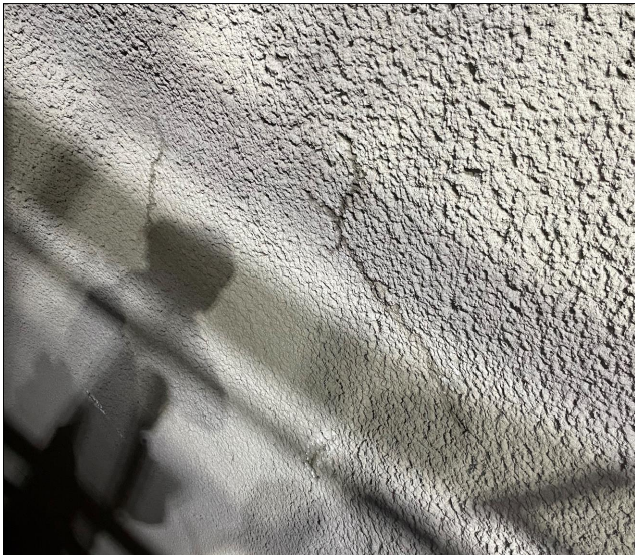
Foto 7. Eksempel på riss i brannsikret PE-skum i tunnelvederlaget.
