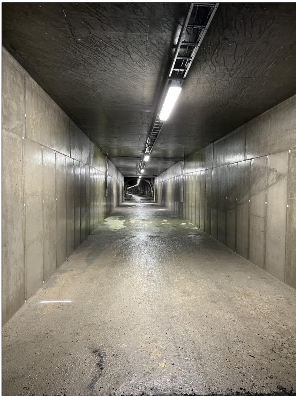
Foto 18: Kulvert leder til utgang ved gateplan. Kulverten fremstår som gjennomgående fuktig.
