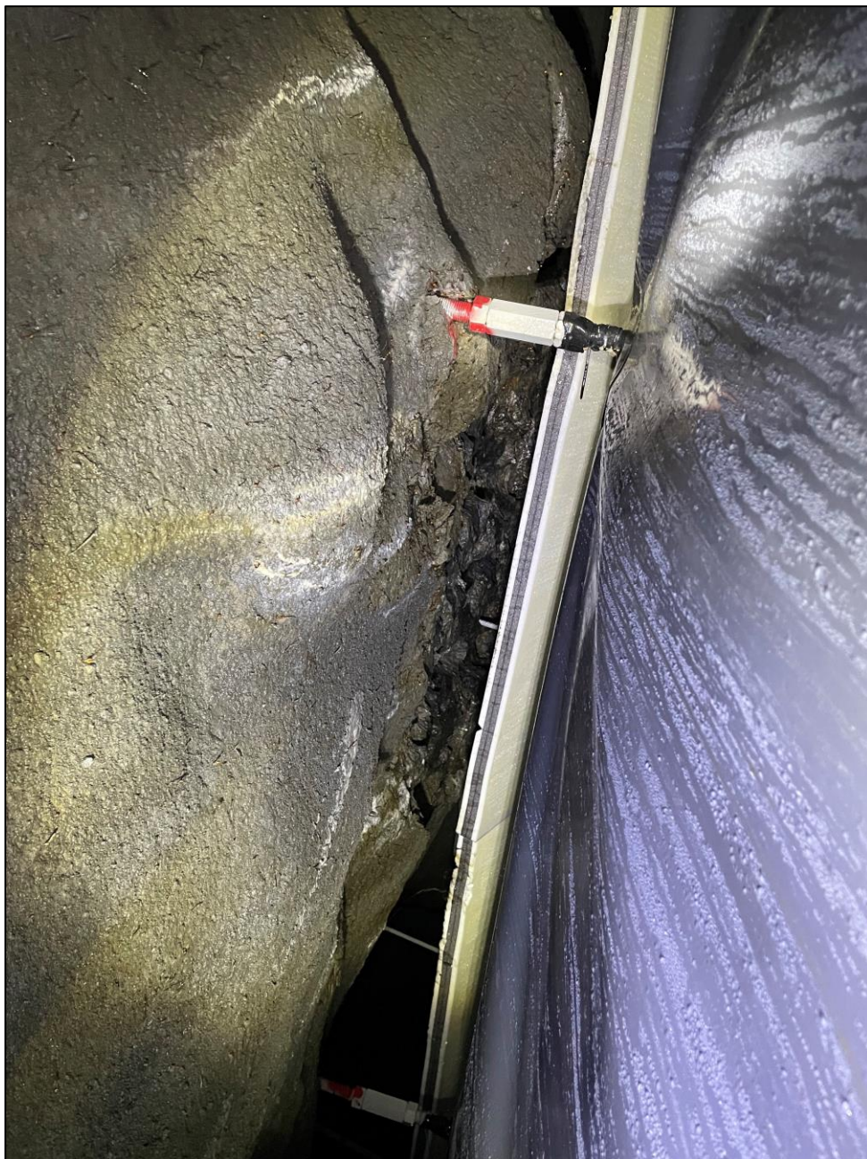
Foto 12. Parti uten sprøytebetongsikring bak hvelv. Gjennomgående fukt i profilet.
