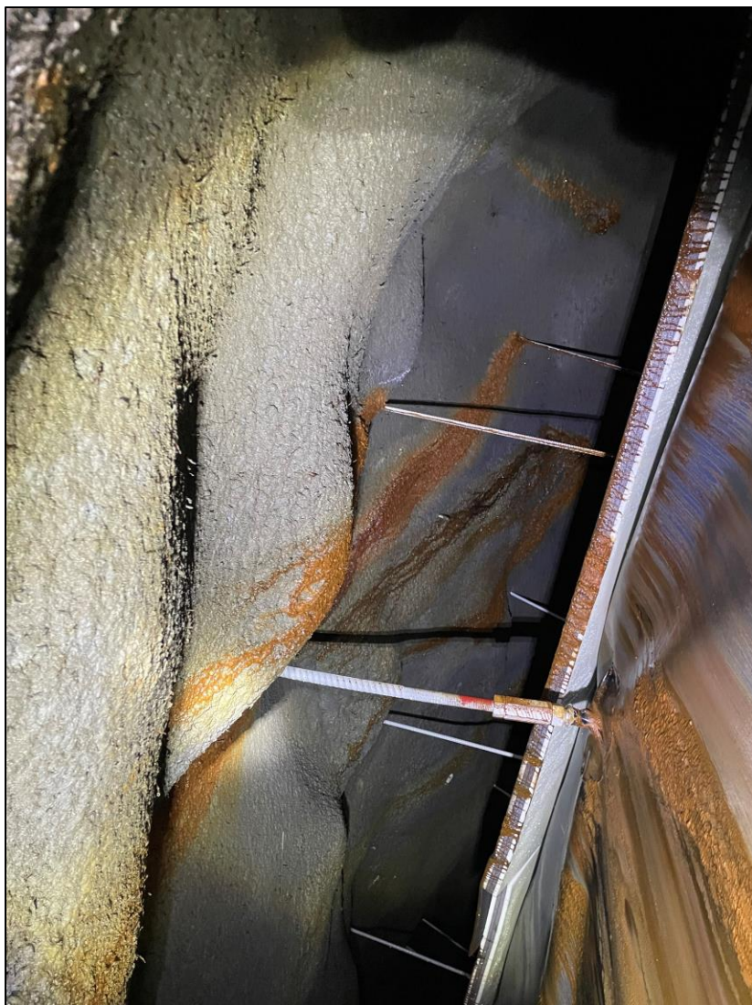
Foto 10. Eksempel på rust fra festebolter for PE-skum.
