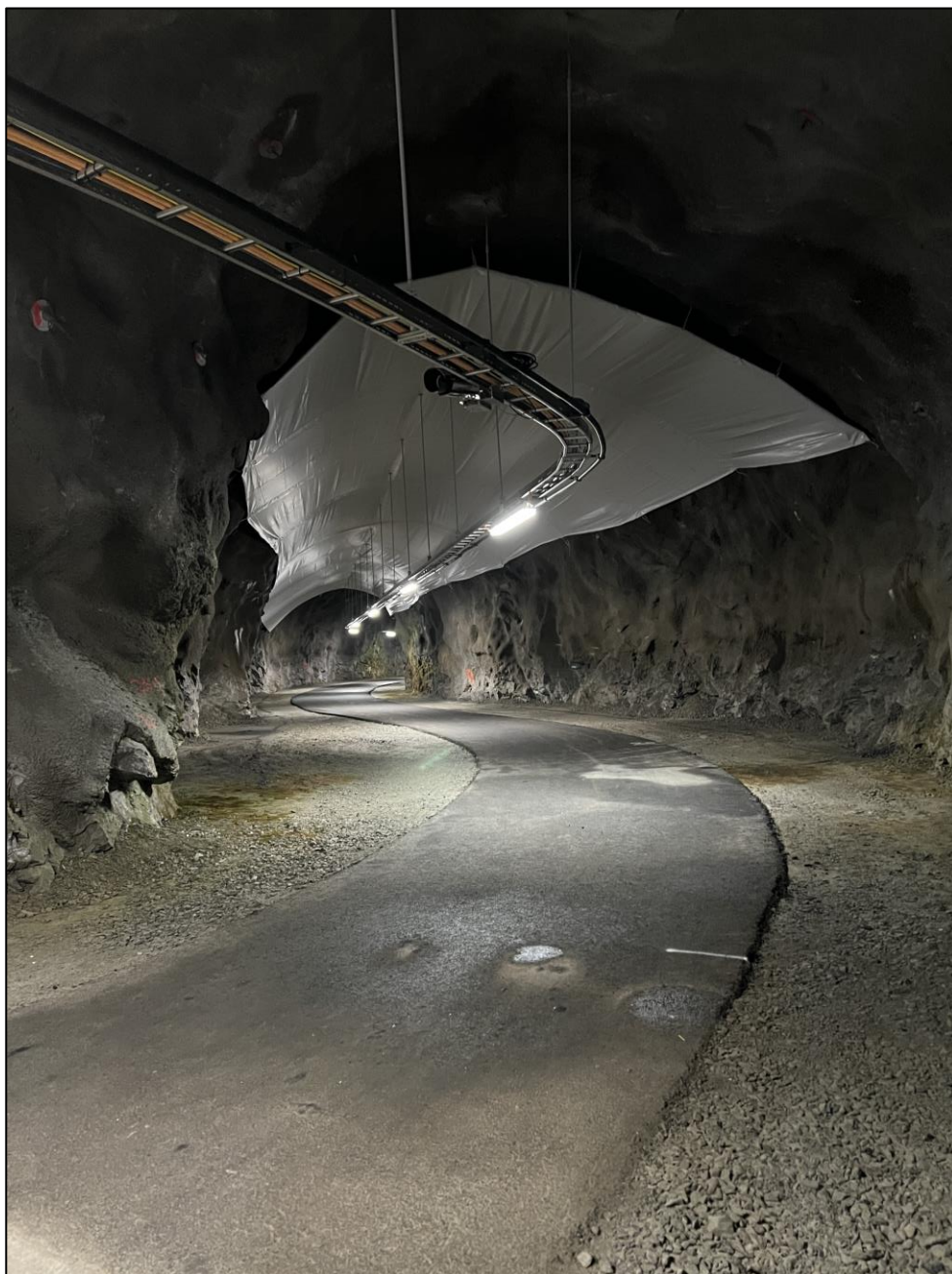
Foto 15: Giertsen tunnelduk montert fra vederlag til vederlag i nødtunnel A. Tunnelen er gjennomgående fuktig med flere dryppsoner, og utfellinger langs sprøytebetongoverflaten og fra bolter.
