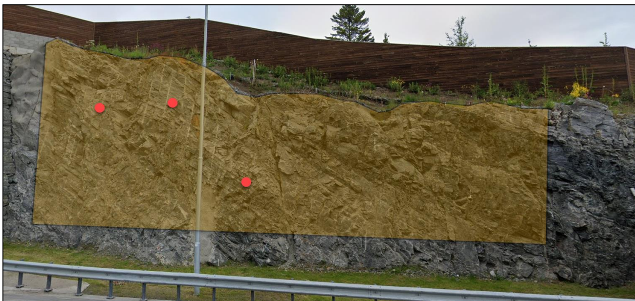
Foto 4. Anbefalt sikringstiltak på forskjæring sør, høyre forskjæringsvegg. Innstøpte bolter er markert med rød og sikringsnett er markert med gul.
